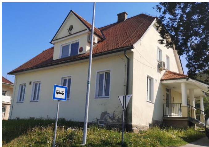
Slika 1: Stara Občinska stavba - Podlehnik 21
